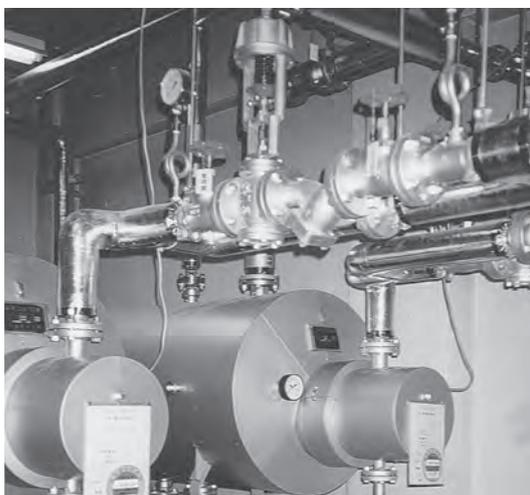
熱交換器と温度調整弁
