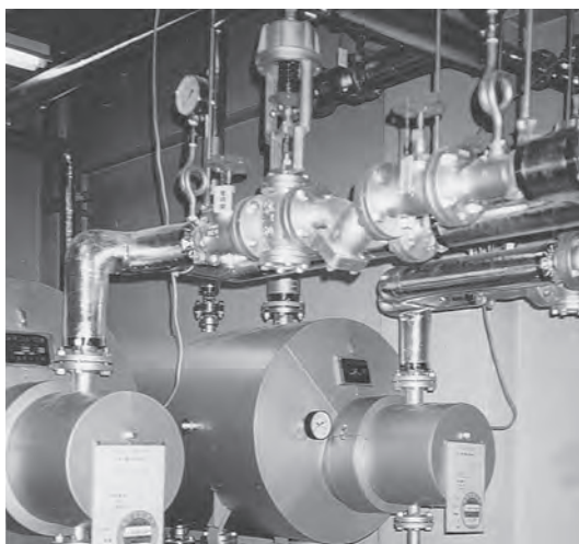
熱交換器と温度調整弁
