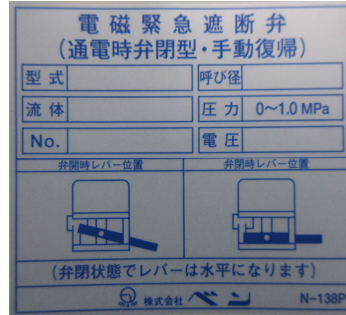
通電時弁閉形の場合
